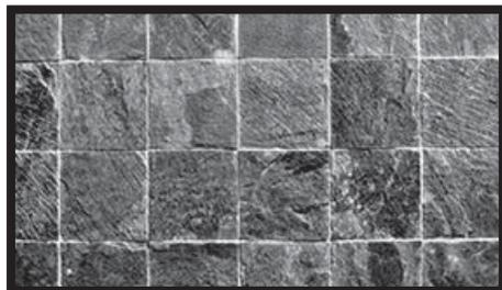
**Рис. 39/40** - Проверить прочность и сцепление с основой. Кроме того, необходимо удалить все следы масел, жиров и воска промывкой раствором воды и каустической соды, после чего аккуратно смыть раствор водой. Если нельзя выполнять химическую обработку, выполнить механическую чистку.
