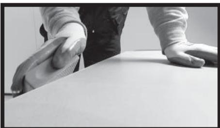
**Рис. 20** - Кромки можно отделывать вручную, используя алмазные губки или наждачную бумагу. Слегка проводя ею по кромке плиты, можно получить эффект затупления кромки или же, проводя ею несколько раз, можно получить эффект снятия фаски.
