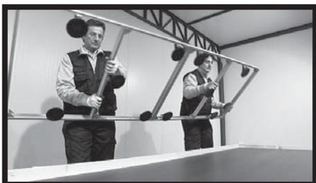
**Рис. 4/5** - Плиты SLIMTECH разных типов в формате 300x100 см можно переносить вдвоем с использованием специальной рамы. Прикрепите раму к плите, когда она еще находится на поддоне. После этого поднимите раму и плиту для устранения эффекта присоски.
