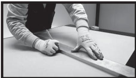
**Рис. 10** - Для получения ровного среза можно использовать алюминиевые рейки, которые обычно используют строители.
