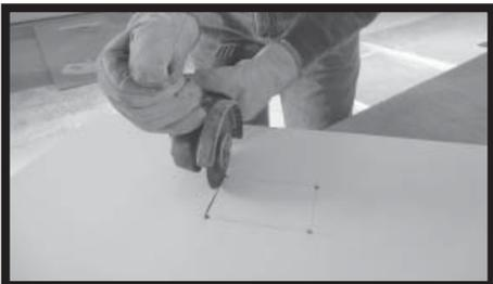
**Рис. 19** - Для получения внутренних вырезов и Г-образных вырезов рекомендуется закруглить кромки проема инструментом с радиусом не менее 5 мм, чтобы снизить опасность поломок. После этого можно продолжить резку алмазными дисками, прекращая движение как только будет достигнуто выполненное ранее отверстие. При сверлении и резке алмазными дисками выполните приведенные выше инструкции.
