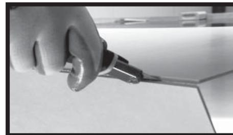
**Рис. 12** - В случае с SLIMTECH 3plus и SLIMTECH 5plus, после надреза керамической части и отлома плиты, нужно разрезать стекловолокно обычным ножом-резаком.
